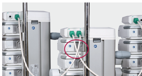
Figure 3: Feil tilkobling av tre søyler: kablene krysses.
